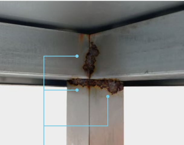
Oxidación por soldadura
